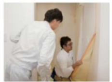
▲設備取り付けに加えて、壁紙の張り替えも学ぶ
