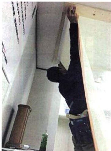
▲天井もクロス張りの練習に活用
