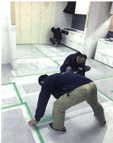
▲養生は毎日剥がして、張り直す
